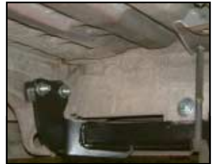
Einbau des Relais
