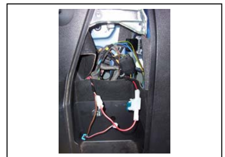
Dauerplus mit Sicherung von rechten zur linken Seite verlegen
